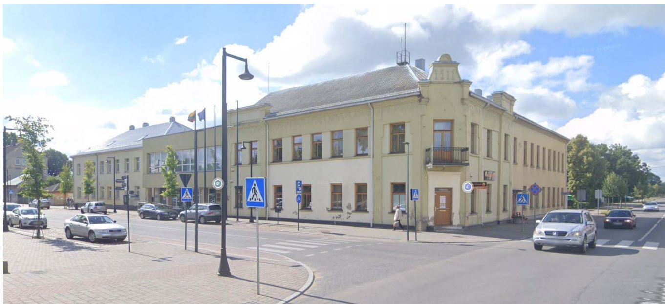
Kalvarijos savivaldybės administracijos pastatų kompleksas
